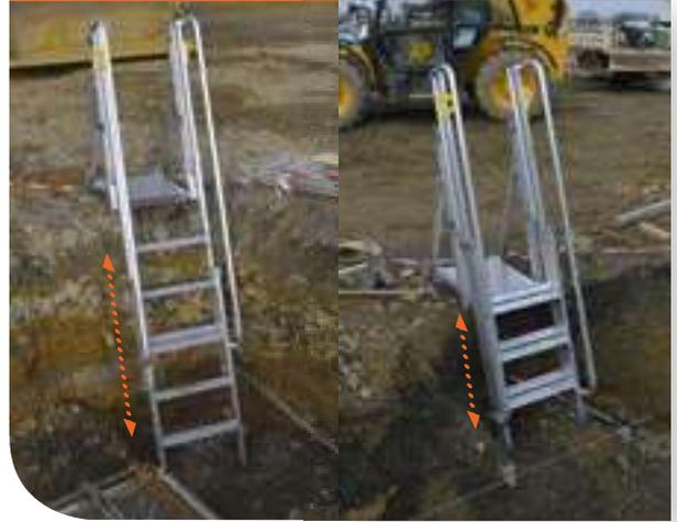
Réglage millimétrique intégré au système anti-basculement du plancher.
